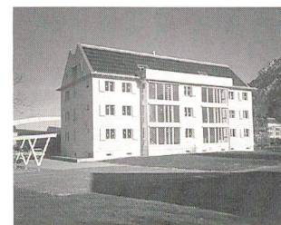
100 m 2 Sonnenkollektoren und gute Wärmedämmung decken rund 80% des Heiz- und Warmwasser-Energiebedarfs dieses 8-Familien-Hauses in Sevelen.
