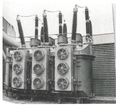
Bild 1 Transformator mit Lärmschutzwand.
