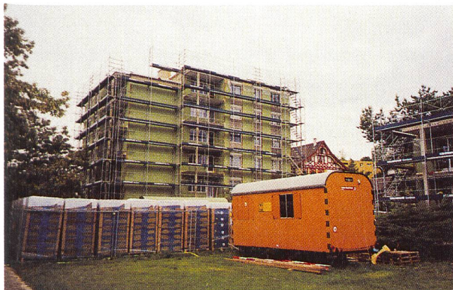
«Energie 2000»: energetische Sanierung von Gebäuden.
