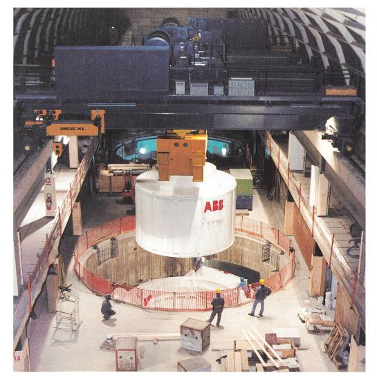
Einbau eines Generatorenrotors für die neue Kavernenzentrale Bieudron (System Cleuson-Dixence, VS).
