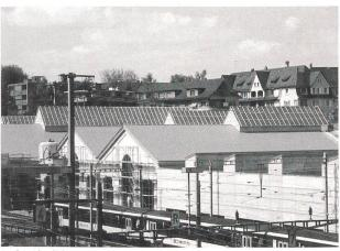
In der Oberlichtverglasung des SBB-Lokdepots wurde eine Photovoltaik realisiert. Im Endausbau liefert sie jährlich 53 000 kWh Strom, der in das Netz des EWB gespiesen und über die Ökostrom-Börse verkauft wird.
