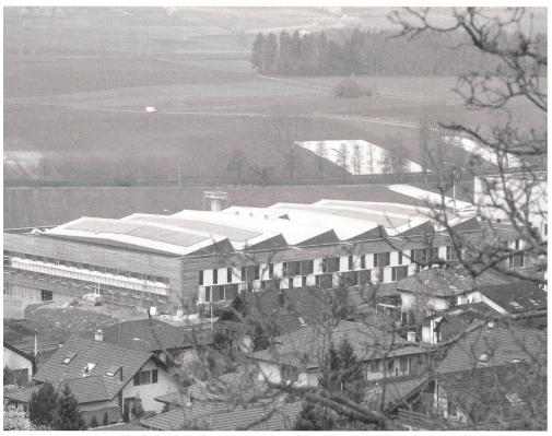
Gesamtansicht der 100-kW<sub>p</sub>-Photovoltaikanlage auf dem Trisa-Neubau 2000. Die Bürstenfabrik ist der grösste Solarstromlieferant der CKW.
