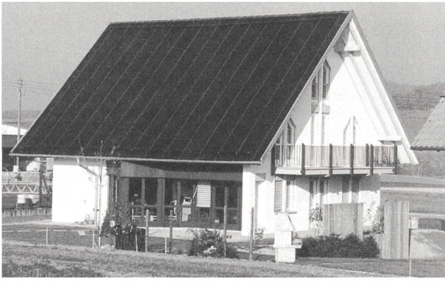
Solarwärmedach: vollständige Integration in die Dachfläche.
