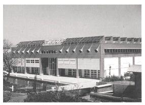
Auf dem Neubau der Abteilung Elektrotechnik befindet sich die 60-kW<sub>p</sub>-Photovoltaik-Testanlage der Ingenieurschule Burgdorf.
