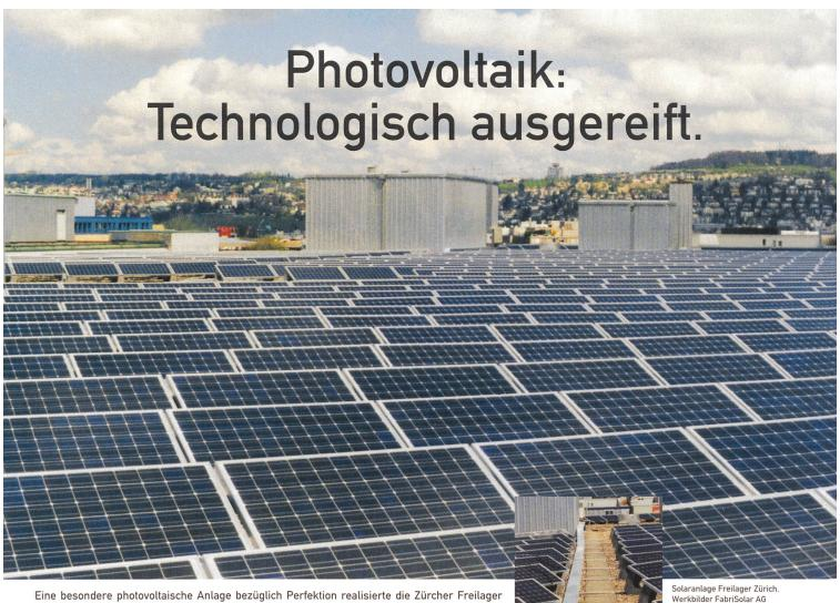
Eine besondere photovoltaische Anlage bezüglich Perfektion realisierte die Zürcher Freilager AG auf ihrem Lagerhaus Block 4. Sie wurde im Rahmen der EWZ Solarstrombörse gebaut und verfügt über eine Leistung von 70 kWP. Mit dem erzeugten Strom von ca. 60'000 kWh pro Jahr können 20 Haushalte mit Strom ganzjährig versorgt werden.
