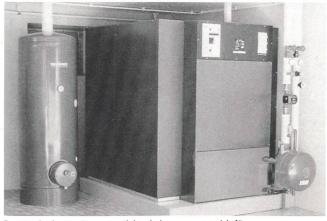
Der Verein der Benützer von Elektroheizungen setzt sich für die Belange dieser Heizungsart ein. Im Bild ein Elektro-Feststoff-Zentralspeicher und 300-Liter-Standspeicher für Brauchwasser.
