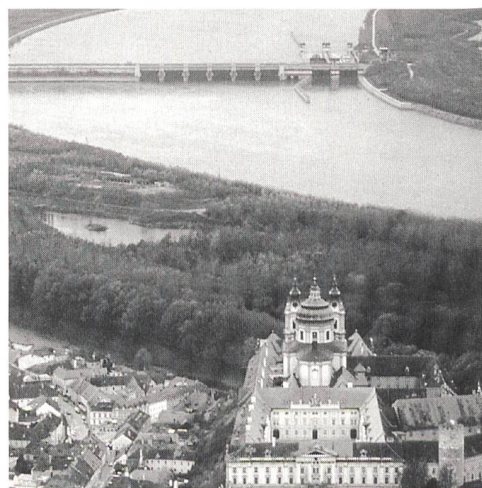
72% Wasserkraft in Österreich (Donaukraftwerk Melk, Bild Verbund).
