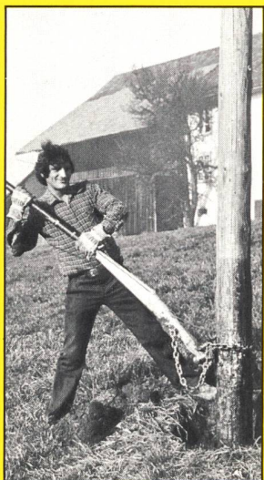
Nachimprägnierung von Holzmasten
