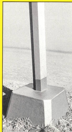
Betonschutz an Mastsockeln
