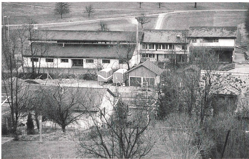
Die Nahwärmeversorgung Bennwil mit Schnitzelheizung wurde Mitte Januar 1998 eingeweiht. Die Elektra Baselland Liestal ist zu 54% am Aktienkapital der Firma beteiligt.
