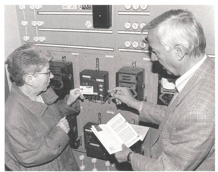
Bild 2 Von der «Smart Card» Strom auf den Zähler laden: 100 Kundinnen und Kunden der Städtischen Werke Baden (StWB) testen in einem auf zwei Jahre befristeten Pilotprojekt ein neuartiges Energiezahlungssystem. Herzstück des Systems ist eine «Smart Card», die Informationen und Kredit für den Energiebezug zwischen Elektrizitätswerk und Haushaltzähler transportiert.
