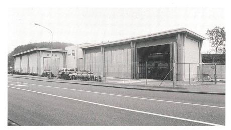
Wegen der engen Platzverhältnisse zieht sich das Unterwerk Balsberg in die Länge. Rechts die zwei Transformatoreneinheiten 110/16 kV, deren Abwärme für die Gebäudeheizung abgezweigt wird.
