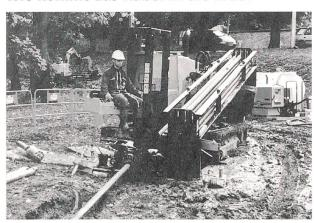
(sl) Je nach Lage, Bebauung und Untergrund werden beim Legen von Stromleitungs-Erdkabel Grabenfräsen, Kabelpflüge, Bohrmaschinen, Bagger oder auch Schaufeln eingesetzt. Sollen Kabel unter Flüssen oder Strassen hindurchgezogen werden, greifen die Stromversorger auf computergesteuerte Bohranlagen zurück. Ein Sender in der Bohrlanze zeigt dem Lenker der Bohrmaschine dabei jederzeit Lage, Tiefe und Neigung des Bohrkopfs an.
