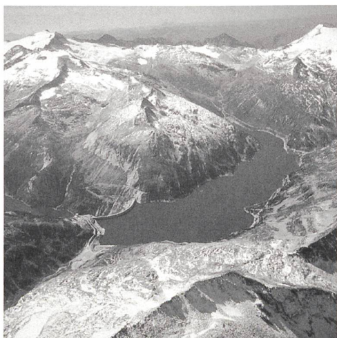
Schutz für die Wasserkraft auch nach der Marktöffnung: Kölnbreinsperre des Malpa-Kraftwerks (A).
