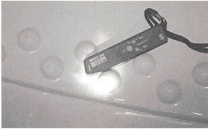
Bild 8 Messungen der Trockenschichtdicke mit elektromagnetischem Schichtmessgerät.
