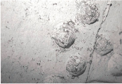
Bild 2 Nieten und die Blechstößen verursachen Wirbelungen.
