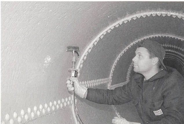
Bild 9 Überprüfung der Porenfreiheit mit Hochspannungsdetektor.
