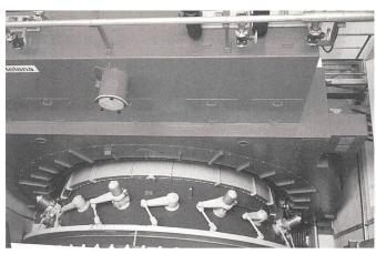
Bild 2 Oberwasserseitige Ansicht der Maschinengruppe mit Einlaufrohr, Leitapparat und Statorgehäuse.
