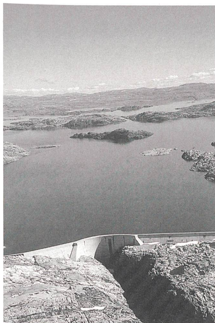
Førevassdammen, Norwegens grösster Betondamm, 95 m hoch, 1300 m breit: elegante Einbettung in die Landschaft mit Gewichtsstauwand und zusätzlicher Bogenstütze (Bild Statkraft).
