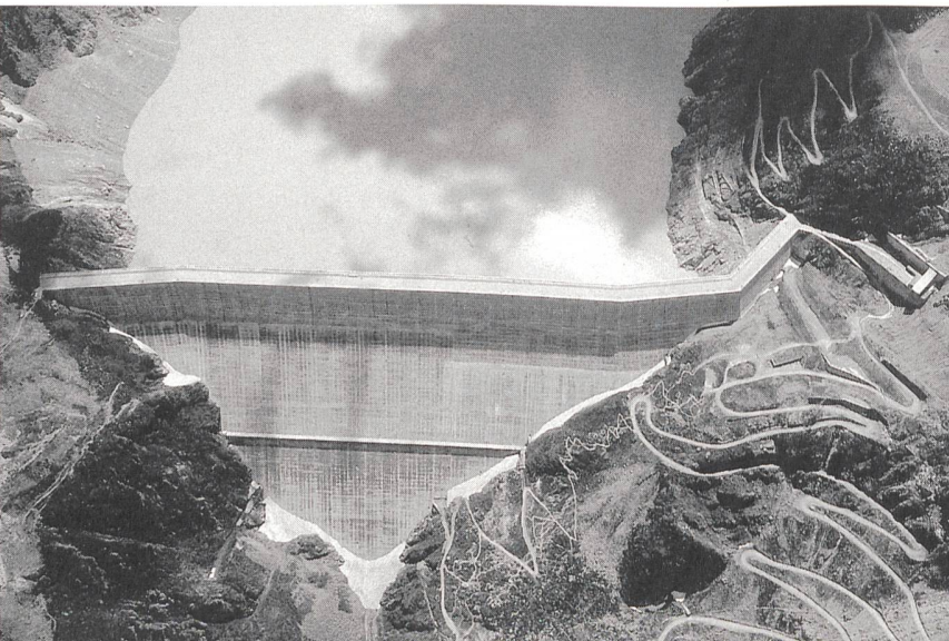
Höchste Gewichtstaumauer der Welt: Grande Dixence (VS, 6 Mio. m 3 Beton): «saubere Lösung» mit leichten Asymmetrien (Photo Germond).
