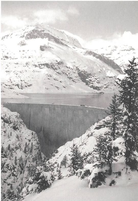
Die Bogenstaumauer von Eposson ist horizontal und vertikal gekrümmt und bietet ein sauberes, mit der Natur harmonisierendes Gesamtbild (Bild Darbellay).
