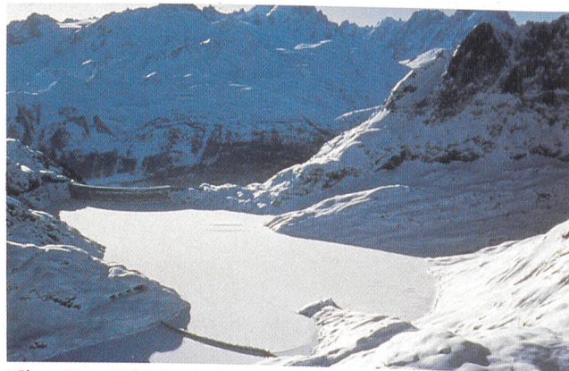
Höhere Stromproduktion dank mehr Wasserkraft (Stausee Emosson/VS).
