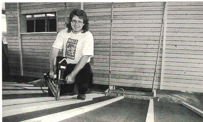
Haus in nur 24 Stunden erstellt: Die einzelnen Teile werden millimetergenau vorproduziert und auf der Baustelle montiert (Foto: F. Beyeler).
