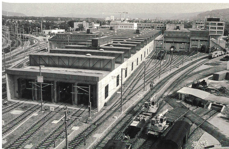
Bild 1 Ausenansicht des neuen Lokdepots Basel für die «Bahn 2000» mit Betriebsremise (links oben), Pendelzughalle (Vordergrund), Werkstattremise und Dieselwerkstätte sowie Bürogebäude (rechts oben). Dieser Gebäudekomplex weist nicht nur in bahntechnischer Hinsicht ein zukunftsgerichtetes Konzept auf, sondern verfügt vor allem auch bezüglich der Beleuchtungstechnik, das heisst bei der Lichtsteuerung, über eine unkonventionelle Lösung. (Fotos: Carlo Gavazzi AG)
