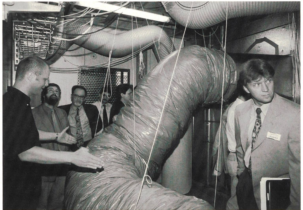
Prüfleiter Beat Hinder (links) erklärt den aufwendigen Prüfvorgang einer Luft/Wasser-Wärmepumpe.
