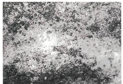
Oberflächliche Salzausblühung auf Betonboden.
