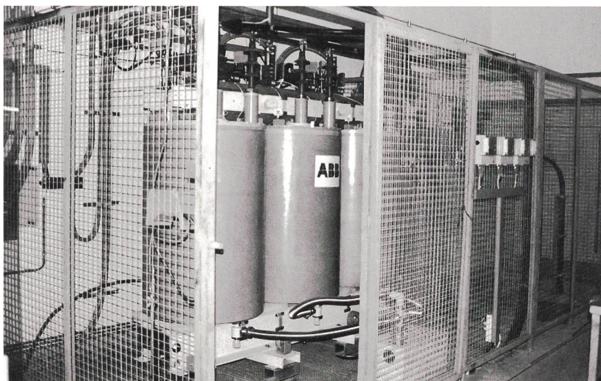
Bild 2 Transformator mit supraleitender Technologie in der Schutzkabine bei den Services Industriels de Genève.
