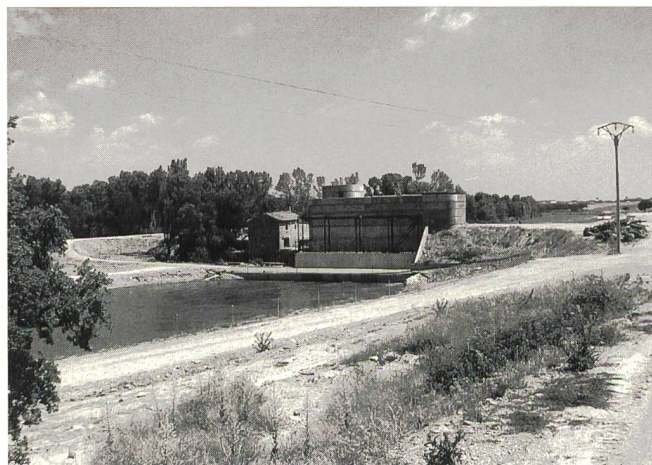
Das Wasserkraftwerk El Hoyo in Spanien nach der Modernisierung.
