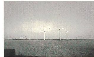
Windkraftanlage bei Alborg (Dänemark).
