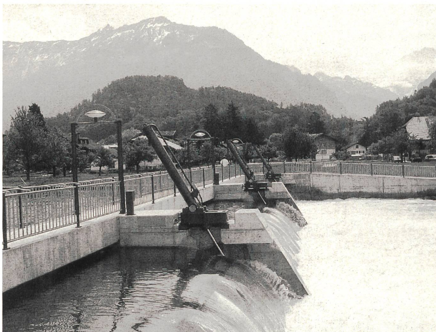
Bereits seit Ende November produziert das neue Dotierkraftwerk in Interlaken Strom. Erwartet wird eine Jahresproduktion von 1,1 Mio. kWh. Das Dotierkraftwerk erforderte Aufwendungen von 2 Mio. Franken, was einen Gestehungspreis von 20 Rappen pro kWh ergibt.
