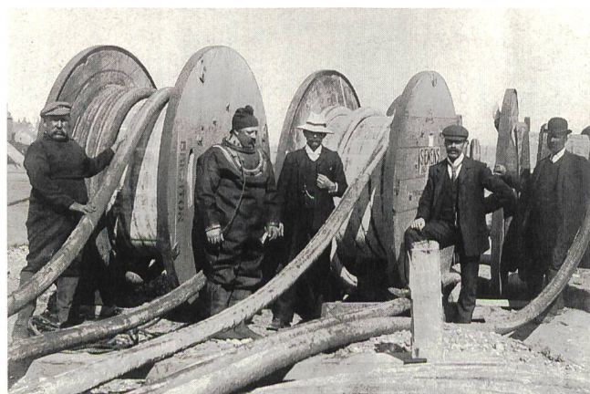
Bild 4 Verlegen von Unterwasserkabeln an der Themse (1863).
