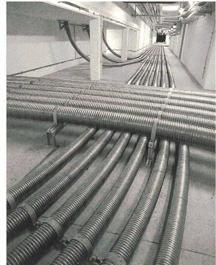
Bild 7 Kreuzende Wellrohrführungen im Kabelkeller
