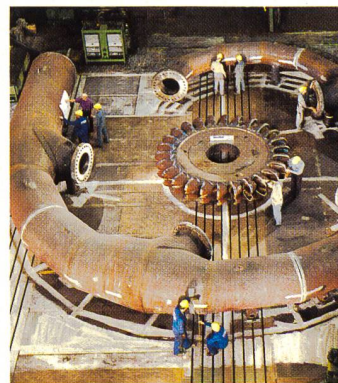
Travaux de dimensionnement pour installer la turbine Pelton dans la nouvelle centrale souterraine de Bieudron (complexe Cleuson-Dixence, VS).
