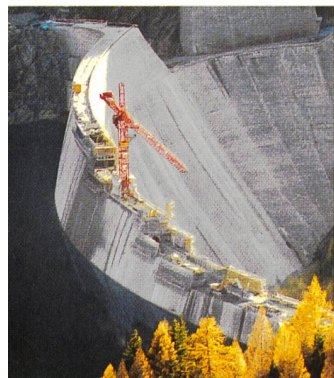
Le barrage de Luzzone (TI) est actuellement surélevé de 17 mètres.
