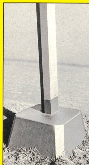
Betonschutz an Mastsockeln
