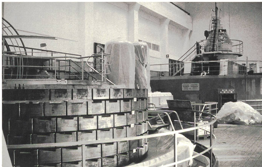
5 Le cercle de fondation du groupe 3 (dont l'alternateur a pris feu) prêt à recevoir un nouveau stator. Le montage d'un nouvel alternateur «sur mesure» nécessitera lui aussi plusieurs mois de travail.
