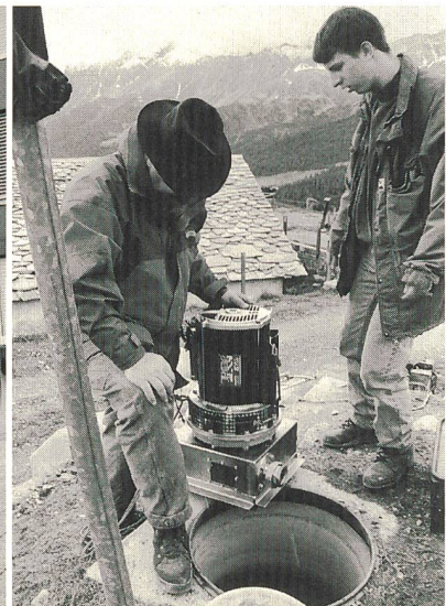
Die angehenden Elektromechaniker der Gewerblich-Industriellen Berufsschule Uster haben 1996 in der 3. Kategorie den 1. Preis gewonnen. Für die Beleuchtung und Käseproduktion auf der Alp Somodoss in Poschiavo bauten sie ein Kleinstwasserkraftwerk (Bild rechts).
