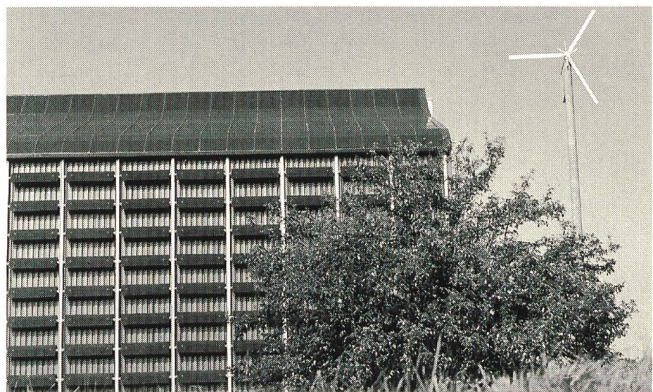
Teilsicht des Daches und der Südfassade des am Neubau angegliederten Hochregallagers; Blick auf die Solarwall – ein speziell perforiertes Fassadenblech mit integrierten Photovoltaikmodulen, das als Wärmeerzeuger eingesetzt wird. Die Photovoltaikanlage besteht aus einem Dach- und aus einem Fassadenteil.
