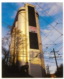
Titelbild: Seit Ende 1996 liefert die erste Photovoltaikanlage, die für die EWZ-Solarstrombörse gebaut wurde, Strom an das Zürcher Netz (Anlage «Sirius» auf dem Getreidesilo der Stadtmühle CMZ: Zellenfläche 232 m², Leistung 32 kVA, Produktion rund 20 000 kWh/Jahr).
