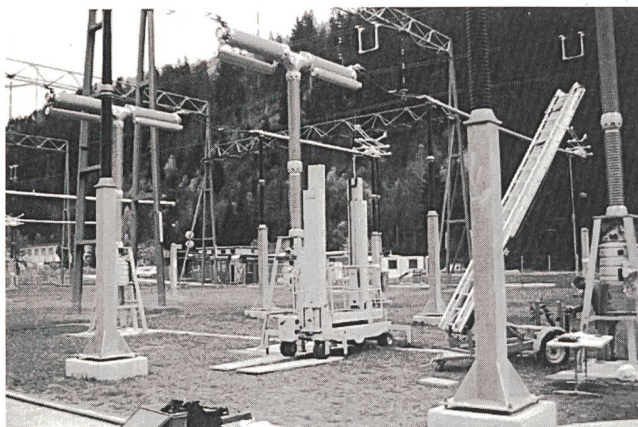
Bild 15 420-kV-63-kA-Leistungsschalter und Steuerkondensatoren mit Verbundrohrisolatoren
