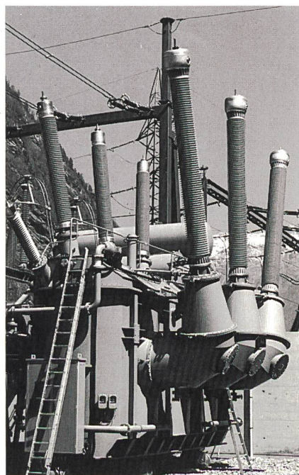
Bild 10 Verbundisolatordurchführungen an 420/220-kV-Leistungstrafo
