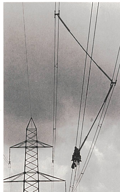
Bild 3 Montage von 400-kV-Phasenabstandhaltern auf der Vorab-Leitung
