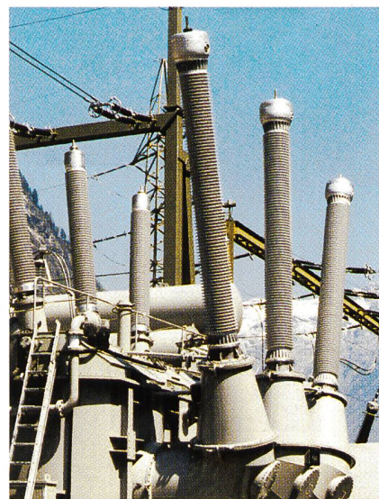
Titelbild: Verbundisolatordurchführungen an 420/220-kV-Leistungstrafo (siehe Artikel S. 19)
