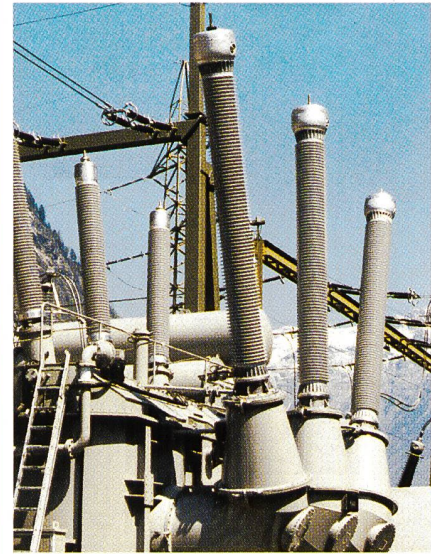
Titelbild: Verbundisolatordurchführungen an 420/220-kV-Leistungstrafo (siehe Artikel S. 19)
