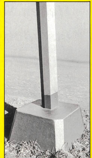
Betonschutz an Mastsockeln
