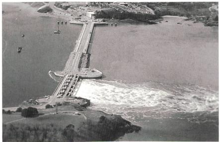
Bild 1 Gezeitenkraftwerk La Rance mit einer Dammlänge von 750 m (Bild EdF).
