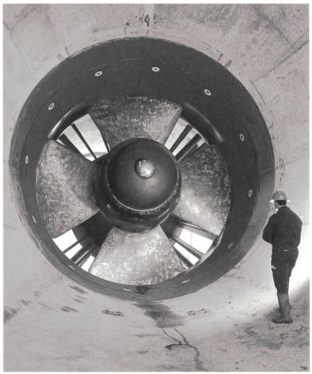
Bild 2 Vierflügelige Kaplan-Rohrturbine mit 5,35 m Laufraddurchmesser (Meerseite, Bild EdF). «C'est impressionant», sprach General de Gaulle anlässlich der Einweihung am 26. November 1966.
