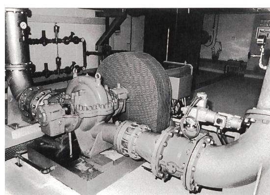
Seit 1993 erzeugt diese als Turbine eingesetzte Standardpumpe (links) mit dem direkt gekoppelten Generator in Nyon (VD) jährlich rund 700 000 kWh Strom aus Abwasser.
