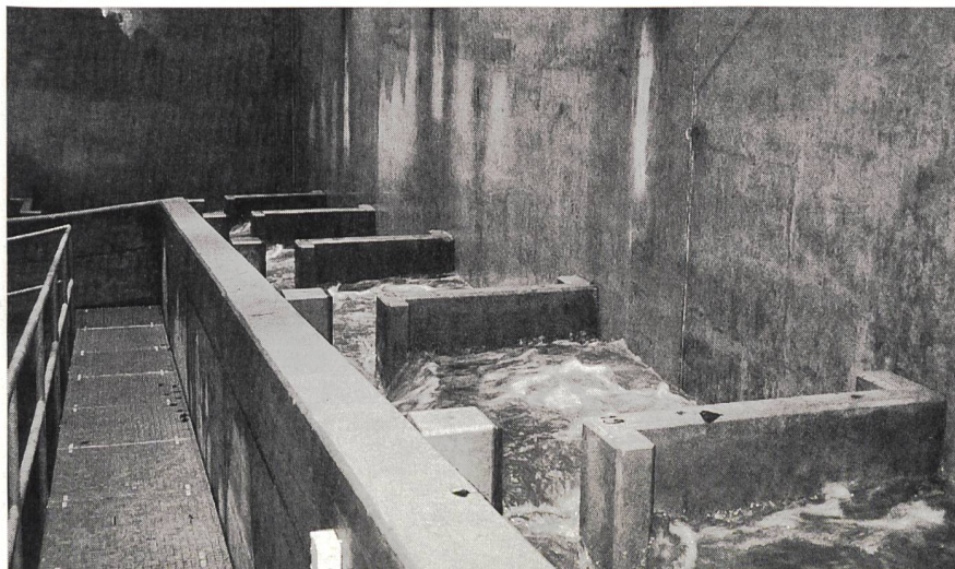
Bild 1 Treppenhausartiges Schachtausbauwerk im Fischpass Aarberg.
