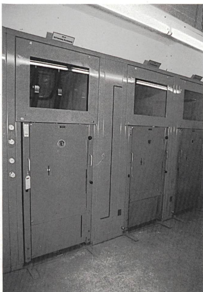
Bild 1 Front TS-Falera/Curnius; nachträglich eingebaute Längstrennung
