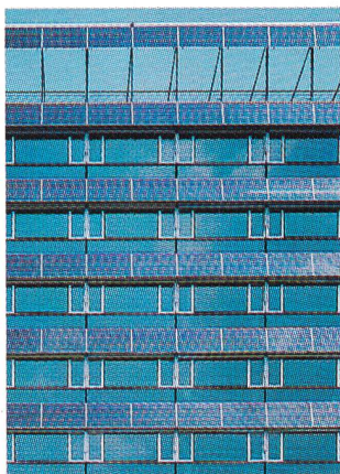
Vorbildliche Integration der Solar- generatoren in die Fassade des Empa- Neubaus in St. Gallen
