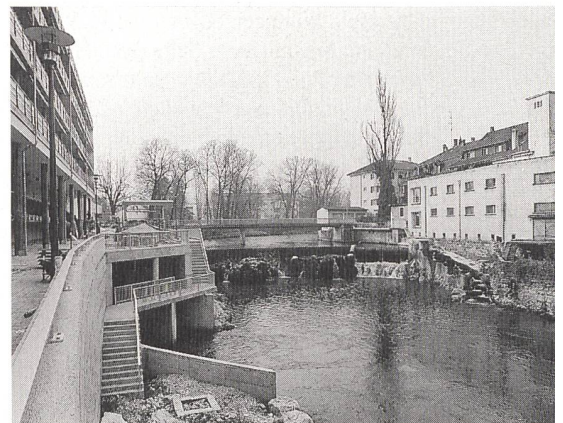
Das neue Kraftwerk in Laufen mit Flusspromenade, im Hintergrund der Wasserfall und rechts davon die Fischtreppe.
