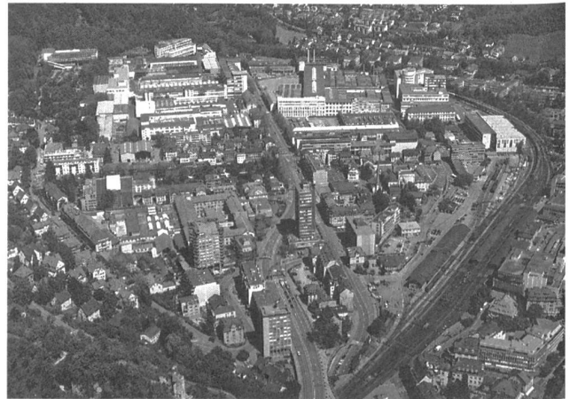
ABB Kraftwerke mit Sitz in Baden.
