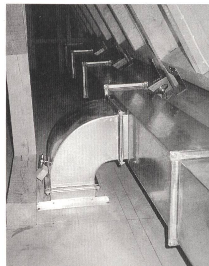
Bild 3 Heissluft-Sammelkanal nach Luftkollektoren.
