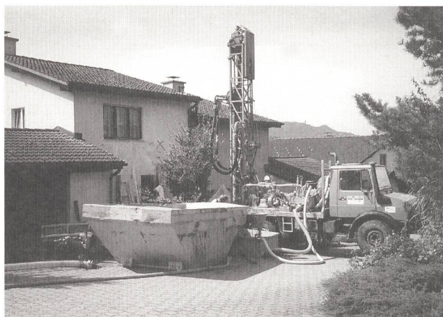
Bild 5 Bohrarbeiten für die Verlegung der Erdsonden zur Heizung eines Einfamilienhauses mit Erdwärme in Gattikon.
