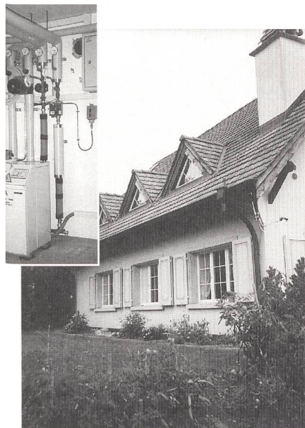
Bild 2 In diesem Einfamilienhaus im zürcherischen Wil im Rafzerfeld liefert eine monovalente Wärmepumpen-Erdsondenanlage umweltfreundliche Heizwärme aus dem Erdreich.
