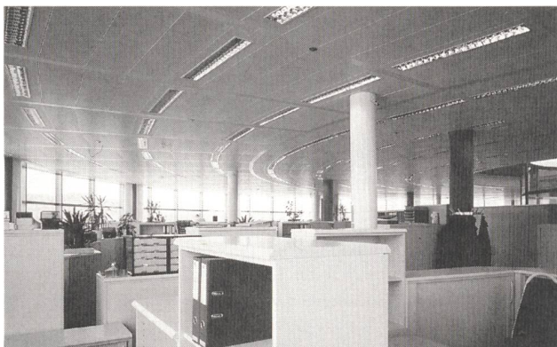
Bild 3 Die Leuchtenreihen sind in der Basiseinstellung über die Lichtmanagement-Installation mit dem Lichtangebot gemäss geschaltet: die am Fenster positionierten Leuchten bleiben bei genügend Tageslichtangebot ausgeschaltet, die mittleren Reihen sind auf einen Mittelwert und die dem Rauminneren zugewandten Leuchten auf 100% gedimmt.
