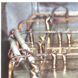
Sämtliche Steinhülsen sind mit der Armierung verschweisst.
