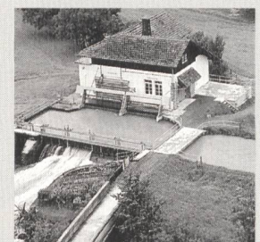
Kleinwasserkraftwerk Hürlimann an der Muota (SZ, 577 kW).
