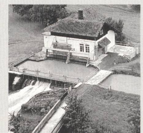
Kleinwasserkraftwerk Hürlimann an der Muota (SZ, 577 kW).
