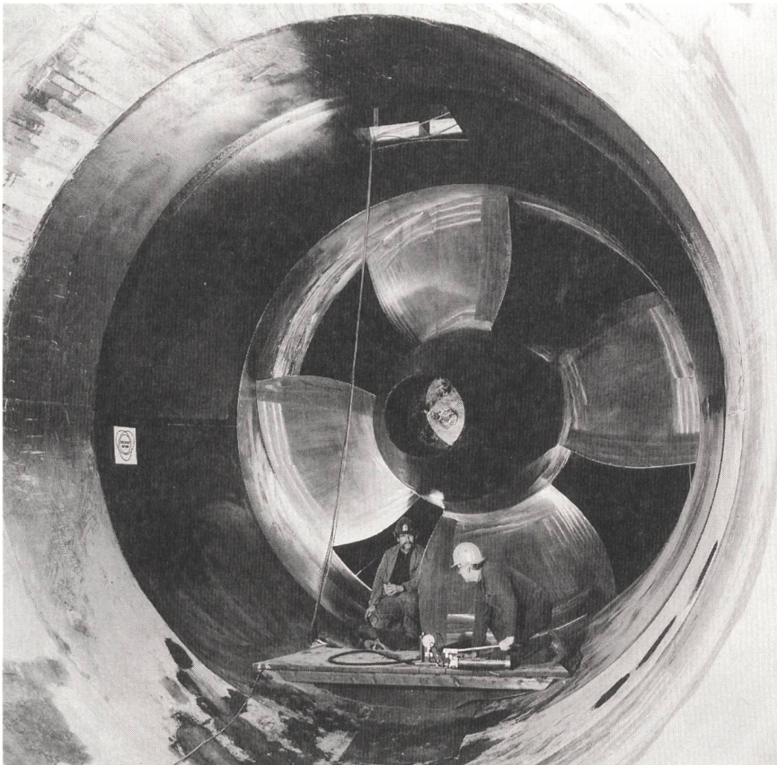
Bild 2 Bei guter Sicherheitskultur in der Arbeit (hier bei der Montage einer Straflo-Turbine) läuft auch in der Freizeit alles runder.
